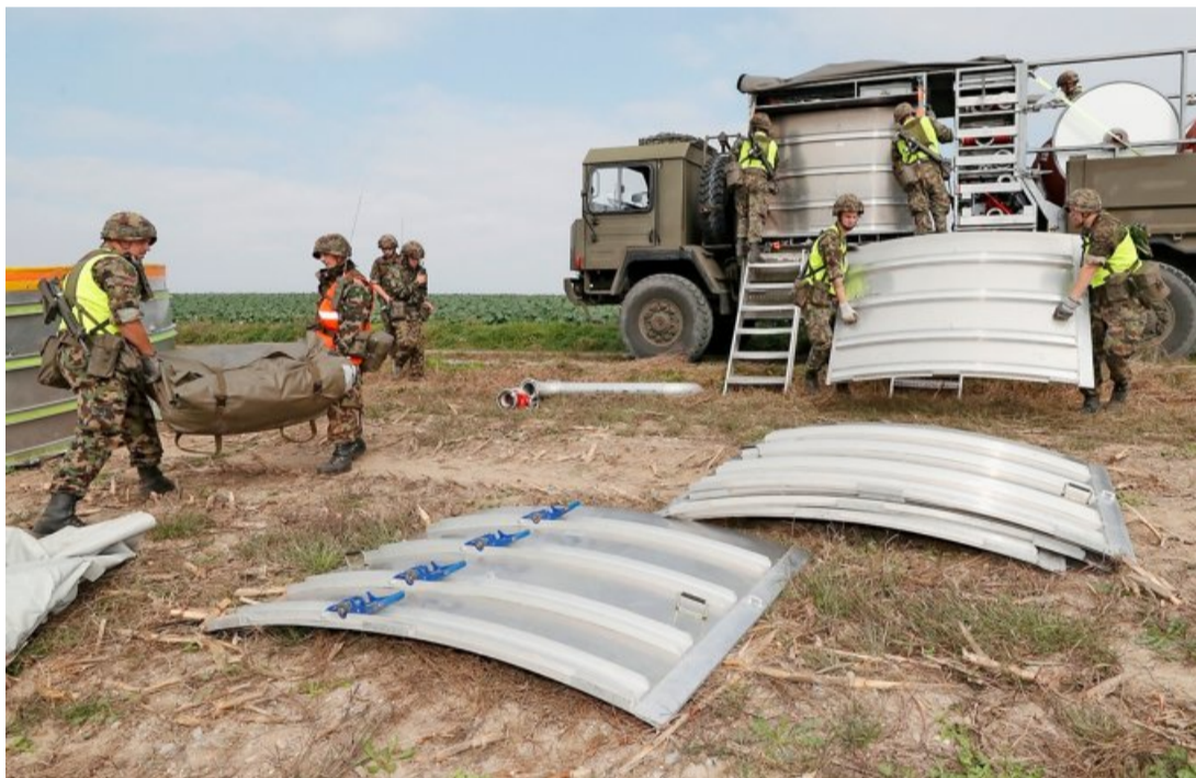
Das Aufstellen diverser Wasserbecken war im teils ansteigenden Gelände notwendig.
